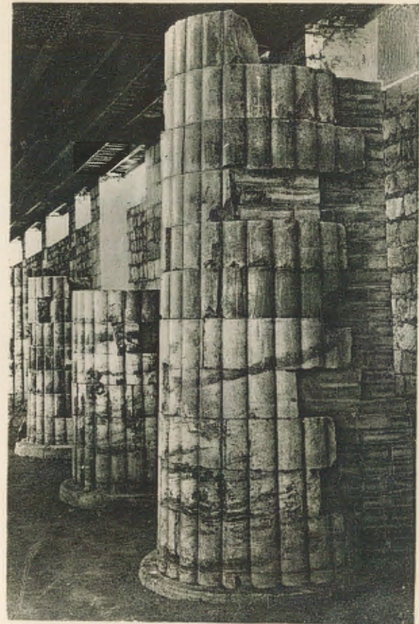
1. Colonnes restaurées avec des briques, avant la pose de l'enduit.
